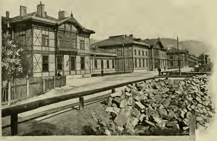
Abb. 260. Aufnahmsgebäude und Restaurationsgebäude Kufstein [Südbahn].
